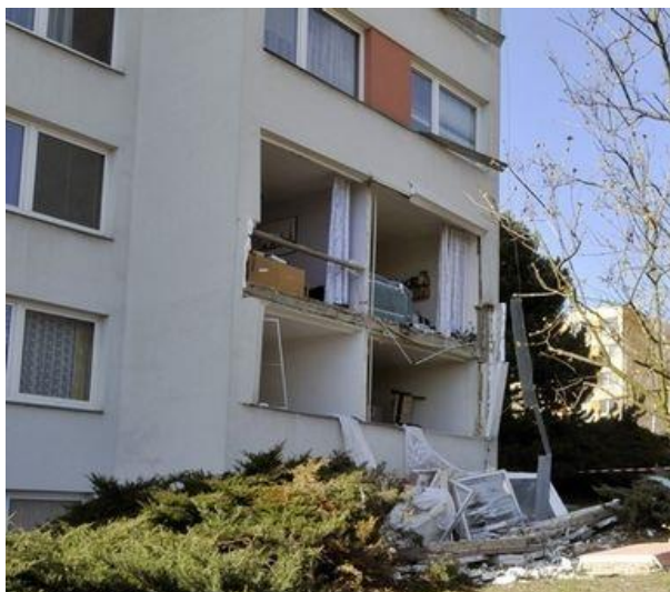
Obr. 29.11 Příklad poškození kombinovaného (smíšeného) systému, blíže viz internetové stránky http://www.novinky.cz/clanek/133908-vybuch-v-byte-v-prazskych-kobylisich-zranil-muze.html .
