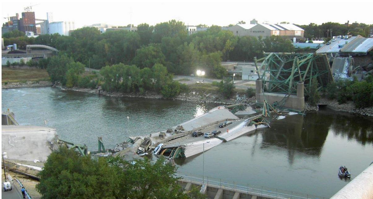
Obr. 21.4 Kolaps I-35W Mississippi River bridge; zdroj [5].
