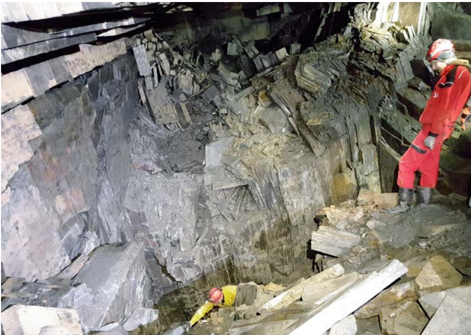
Potlachový důl / Podzemní lom Adama Kunze I, Nízký Jeseník | Důl je ve fázi postupného kolapsu. Stěny a stropy se deformují a bortí, podél rozevřených puklin zatéká do podzemí jíl a části chodeb intenzivně promrzají | Jan Lenart, 2016.
